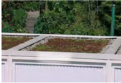
Extensive Dachbegrünung mit Attikaverblendung
