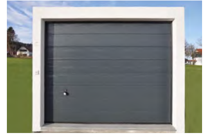
Sektionaltor anthrazit, Einbau hinter der Leibung
