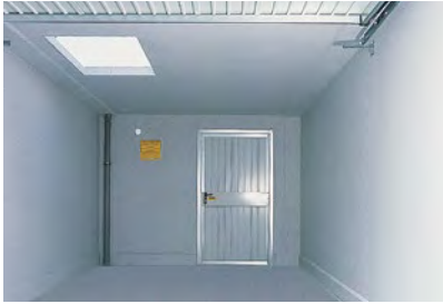
Innenentwässerung, Stahltüre, Deckenaussparung
