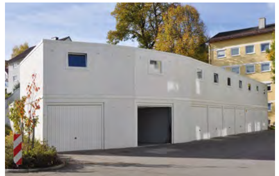
Garage mit angehängter Betonplatte auf Stützen gestellt
