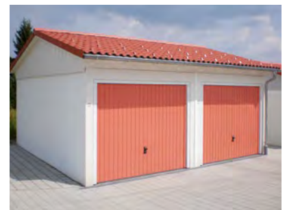
Holztor (bauseits) gestrichen
