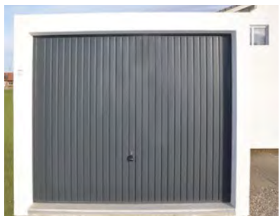
Schwingtor, Einbau hinter der Leibung
