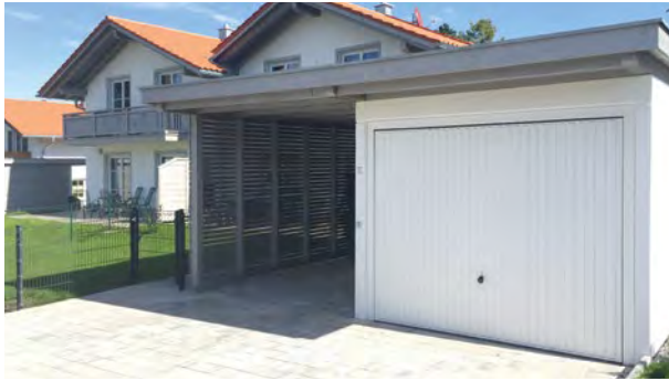
Garage mit angehängter Betonplatte auf Stützen gestellt
