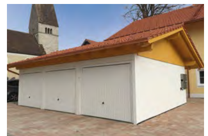
Garagen mit Satteldach
