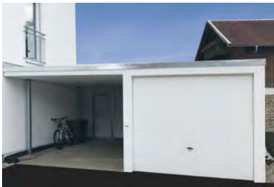
Garage mit seitlichem Carport
